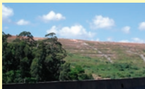
Foto da Área de Apoio DME Lixotal. Fonte: Levantamento de campo - abr/mai 2005.
