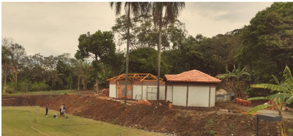
Figura 36 - Vestiários construídos com projeto da Engenheira Ilse, baseados em projeto desenvolvido pelo Caetés. Fonte: Caetés, outubro 2017
