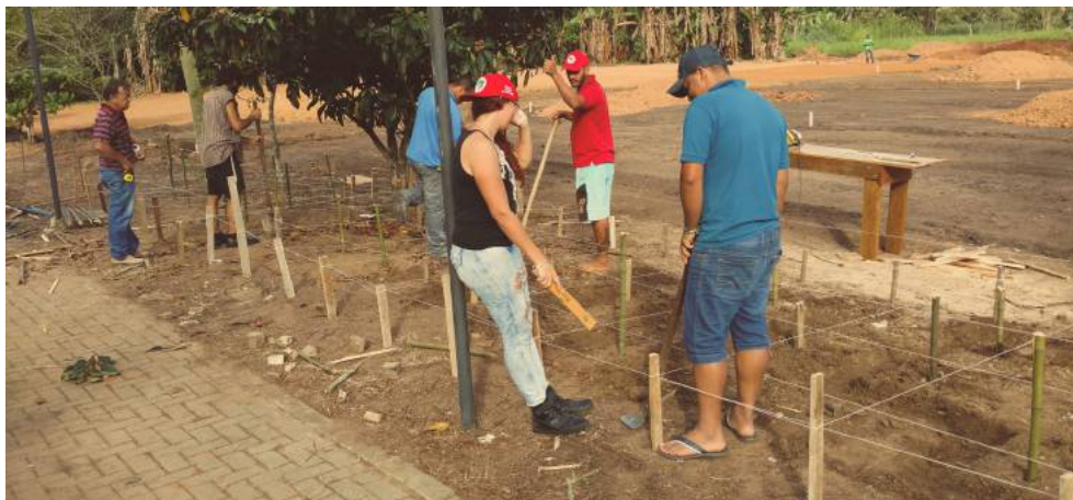
Figura 66 - Construção de um 'grid' com estacas de madeira e linhas de pedreiro, para demarcar as fundações da arquibancada. Fonte: Caetés 2017
