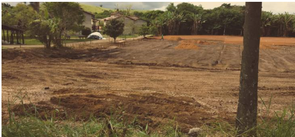
Figura 37 - Vista do campo durante obra, desde o platô dos vestiários. Fonte: Caetés, Abril 2017
