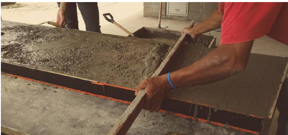
Figura 15 - Argamassagem da fôrma do assento na mesa vibratória. Fonte: Caetés, 2017
