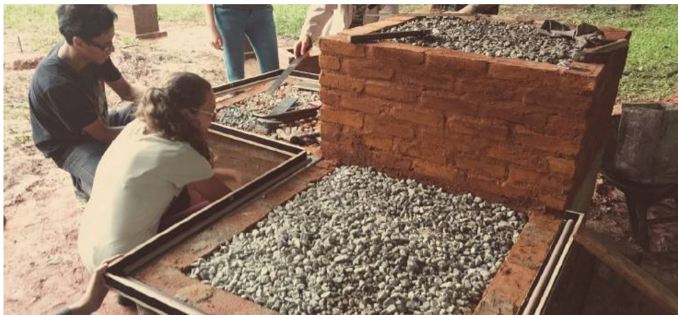
Figura 24 - Preenchimento do interior do módulo cúbico com terra e brita; montagem de fôrmas para os assentos. Fonte: Caetés, 2017
