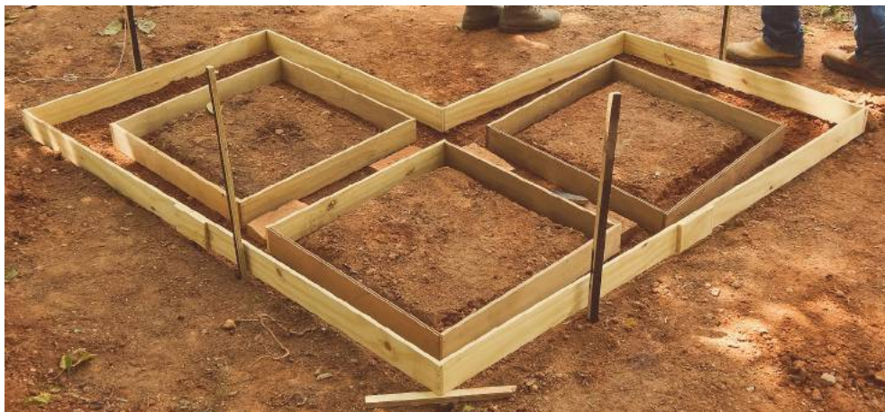
Figura 22 - Montagem das fôrmas para fundação do módulo cubos. Fonte: Caetés, 2017
