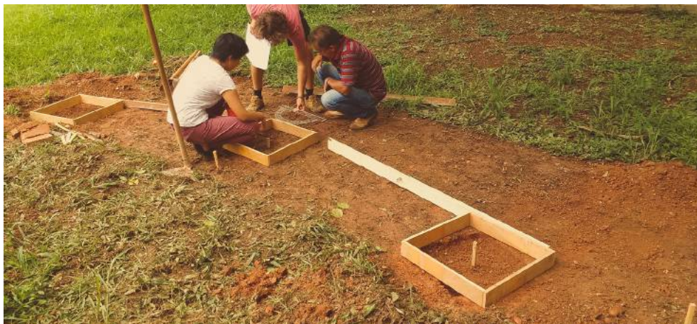
Figura 12 - Montagem das fôrmas para fundação do módulo três apoios, Fonte: Caetés, 2017
