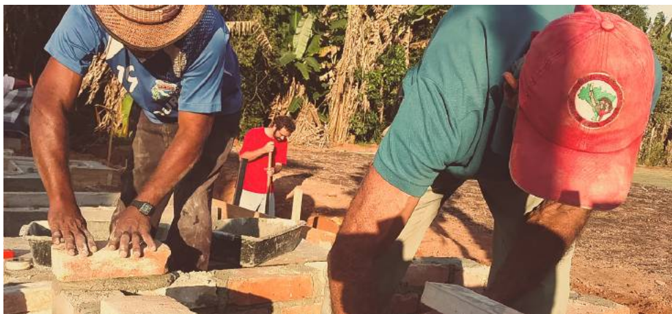
Figura 40 - Chicão (esquerda) e Alacrino (direita), Trabalhadores Aprendizes Voluntários, assentando blocos Fonte: Caetés 2017
