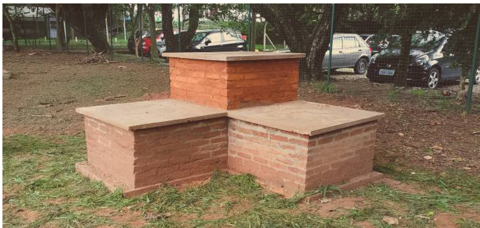
Figura 25 - Módulo cubos finalizado. Fonte: Caetés, 2017
