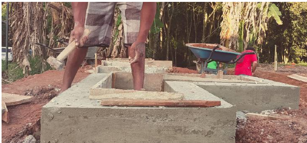
Figura 68 - Desmonte das fôrmas das sapatas de fundação. Fonte: Caetés, 2017
