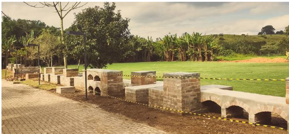
Figura 77 - Vista das arquibancadas recém finalizadas, a partir da passagem pavimentada. Fonte: Caetés, 2017
