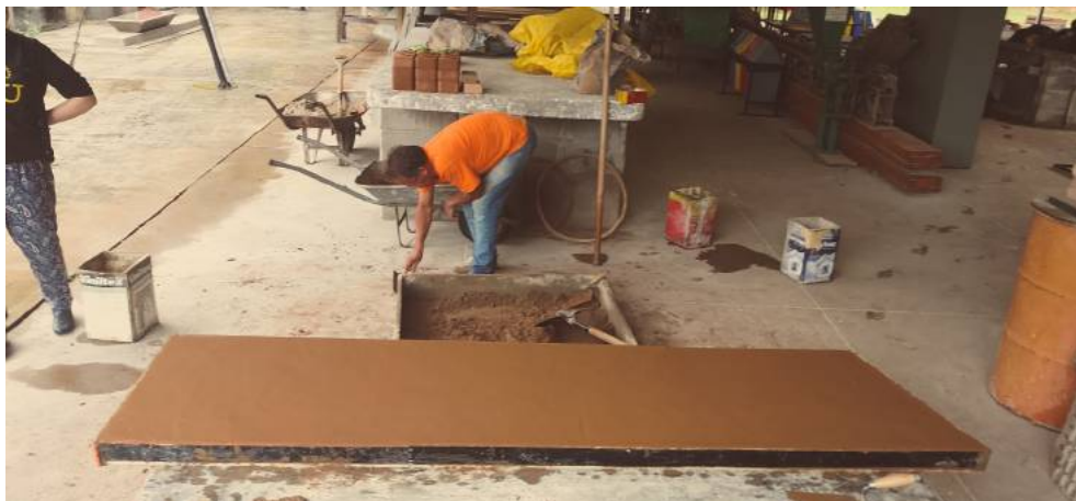
Figura 16 - Argamassagem da fôrma do segundo assento, utilizando terra no traço. Fonte: Caetés, 2017
