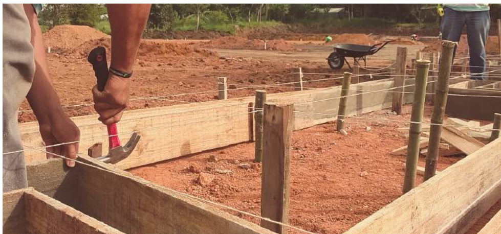
Figura 67 - Montagem das fôrmas para fundação das arquibancadas. Fonte: Caetés, 2017
