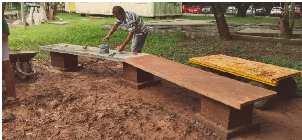
Figura 17 - Módulo três apoios finalizado com os dois assentos, um com argamassa comum e outro incluindo terra Fonte: Caetés, 2017
