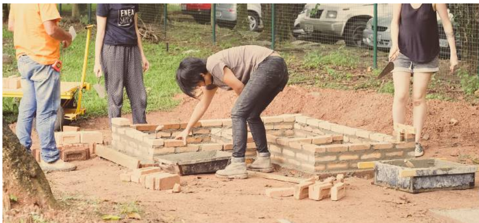
Figura 23 - Levantamento de paredes do módulo cubos. Fonte: Caetés, 2017
