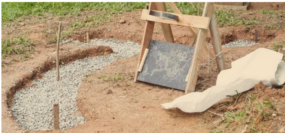
Figura 19 - Brita pilada na base da fundação do módulo hiperadobe; ao lado a estrutura do cavalete para apoiar o saco de rafia durante a construção. Fonte: Caetés, 2017
