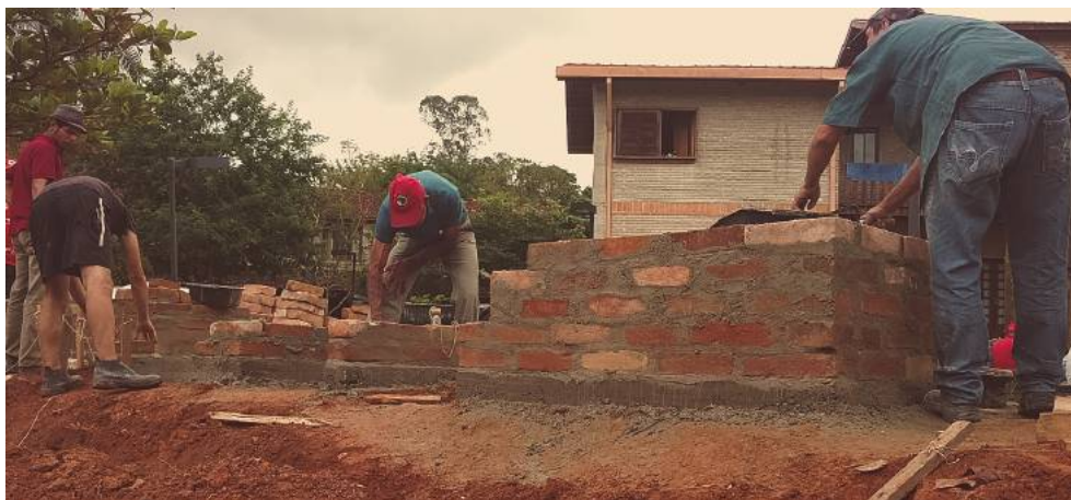
Figura 71 - Assentamento de blocos da arquivada pelos Trabalhadores Aprendizes Voluntários. Fonte: Caetés, 2017
