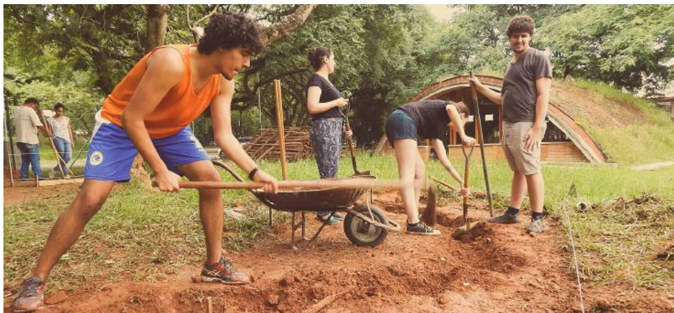
Figura 18 - Escavação da fundação para o módulo hiperadobe. Fonte: Caetés, 2017
