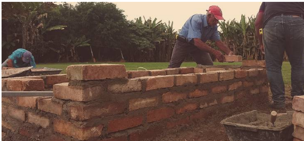
Figura 72 - Assentamento de blocos da arquibancada. Fonte: Caetés, 2017
